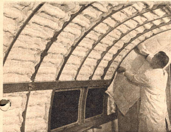
Zwischen den Kabinenwänden des Flugzeugs wird Luft in Glaswolle gebettet und dient so als Isolations-schicht gegen Schall- und Temperaturschwankungen.
